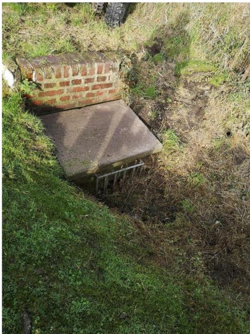
Abbildung 4-2: Einlauf des Gewässers 3.12 in die Gewässerverrohrung (Bestand 2021)
