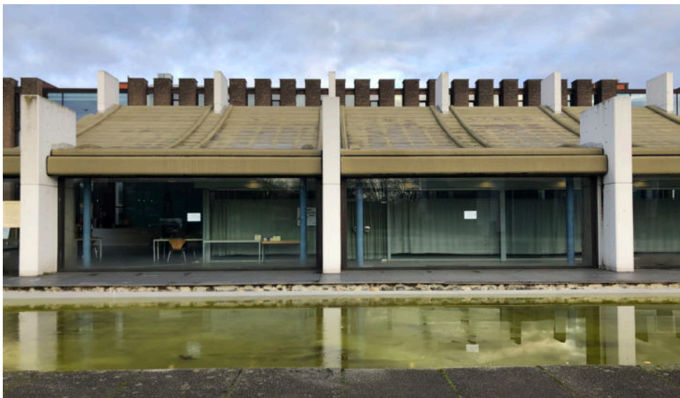
Abb. 9: Ratssaaltrakt mit reaktiviertem Wasserbecken auf der Forumsfläche (Klanten 2021)
