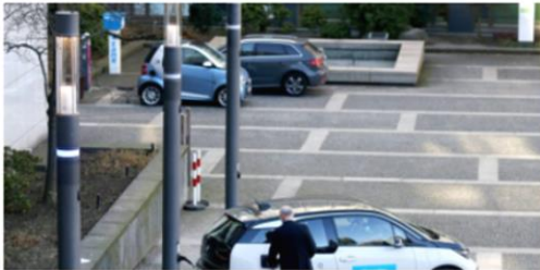
Smart Poles wie hier in Essen können als WLAN-Router und Ladesäule für Elektroautos dienen, außerdem können sie Bewegungsströme und Umweltdaten sammeln. © picture alliance/dpa
