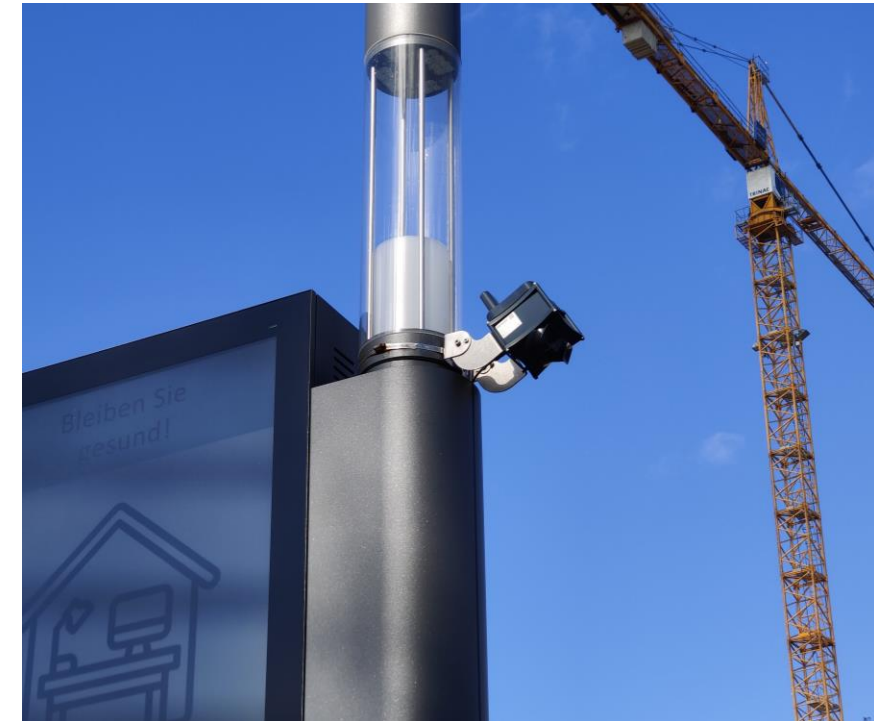
Smart Pole mit Kamera und Bildschirm
